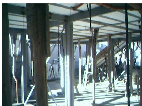
Vista general de pórticos metálicos dúctiles con solución de nudo para viviendas con losa alivianada metálica o steel-deck
