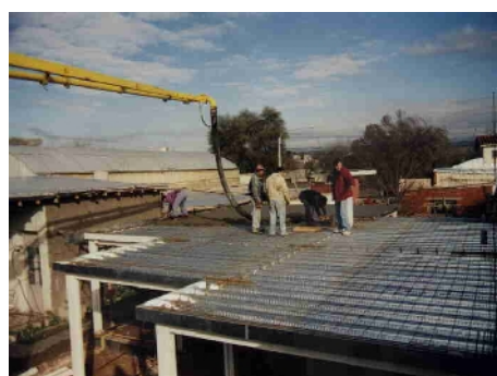
Vista general de pórticos metálicos dúctiles con solución de nudo para viviendas con losa alivianada metálica o steel-deck
