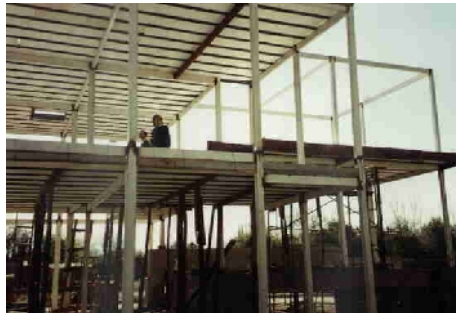
Proceso de montaje para estructuras en altura
